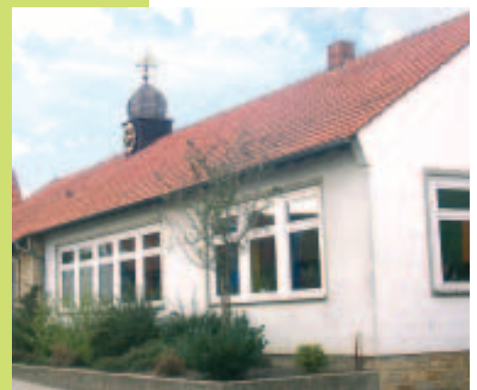
Auch für die Grundschule Borgloh soll der Energiebedarf untersucht werden.
